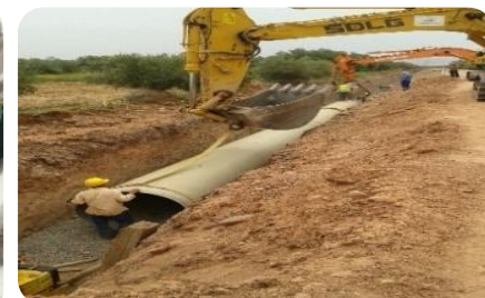
Pose de la conduite principale Amont T2
